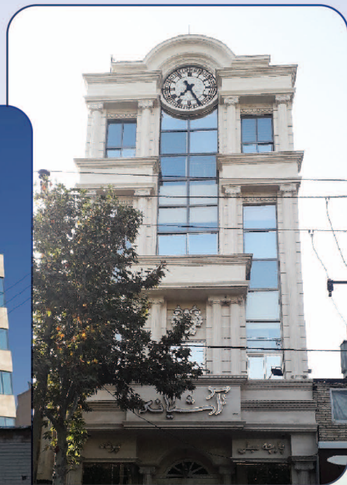
پروژه مسکونی تجاری آشیانه - مشهد چیلر هوا خنک و فن کویل
