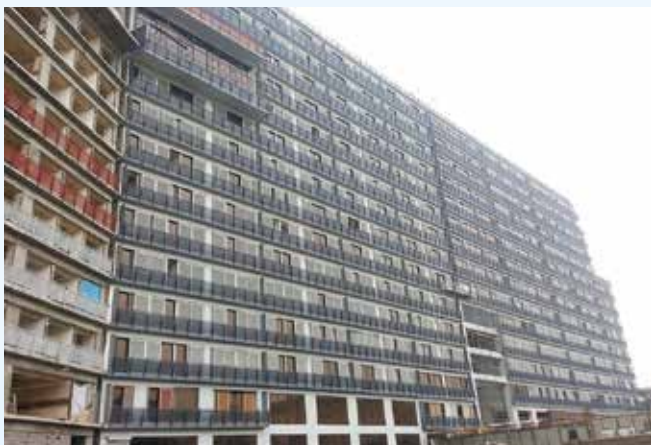
مجتمع های مسکونی افق اکباتان تهران - تهران
